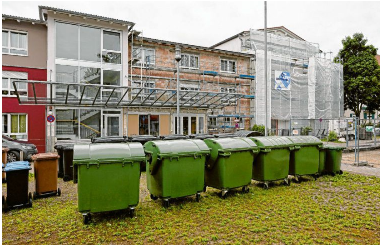
Der Mülltonnenunterstand am Christian-Dierig-Haus brannte aus. Die Mülltonnen stehen nun auf dem Kiesplatz davor. Die Fassade muss ebenfalls erneuert werden. Fotos: Michael Hochgemuth
