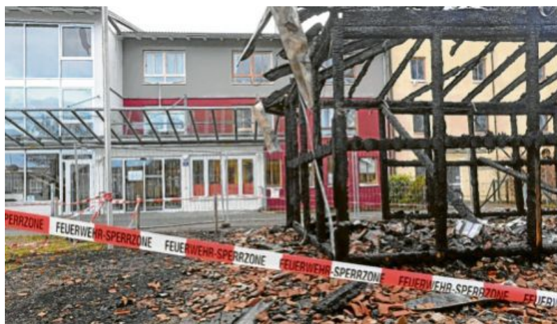
Ende November brannte der Mülltonnenunterstand – übrig blieb ein Holzgerippe. Die Polizei geht von Brandstiftung aus. Foto: Marcus Merk
